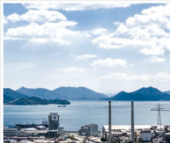
海沿いの施設・海水ポンプ
