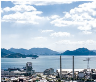
海沿いの施設・海水ポンプ
